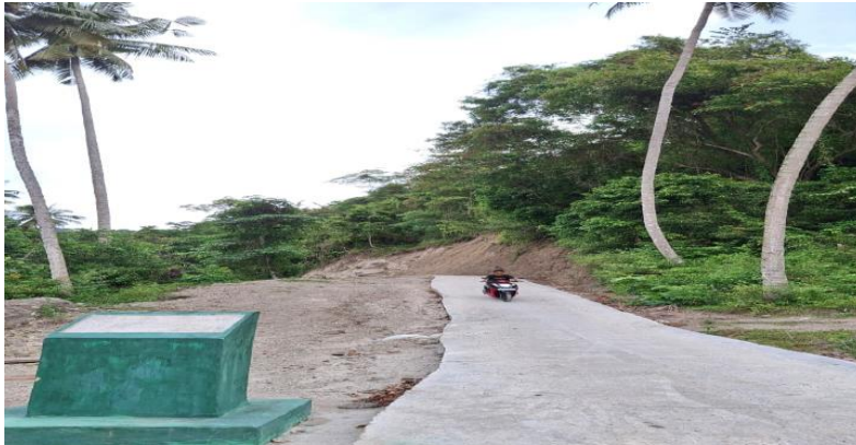
Gambar 4 Pembangunan Jalan Rabat Telah Selesai
