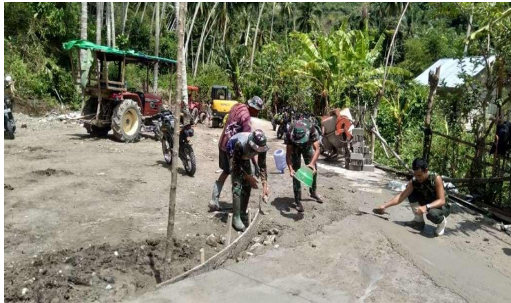
Gambar 2 Pengecoran Jalan Rabat Beton
