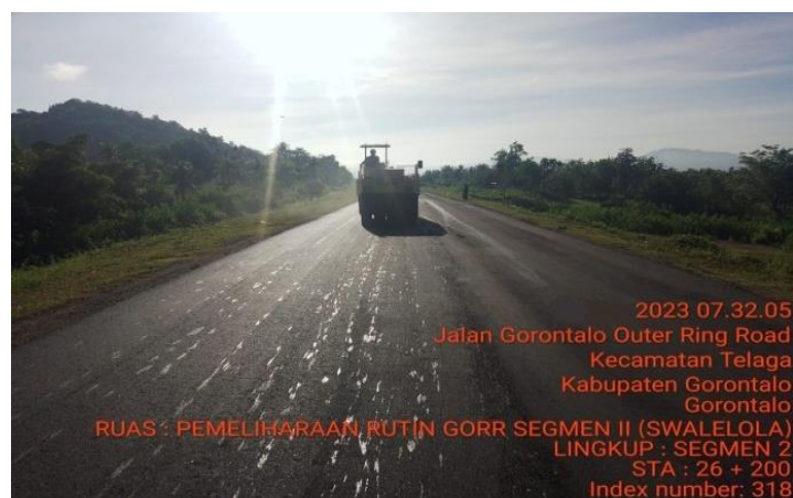
Gambar 3.3 Pemadatan menggunakan TR Sumber :Dokumentasi
