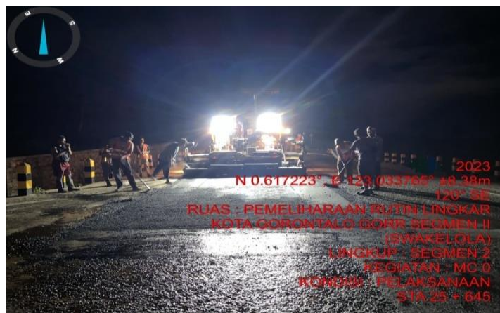
Gambar 3.1 Pekerjaan Hampanan Aspal Panas AC-WC Sumber :Dokumentasi
