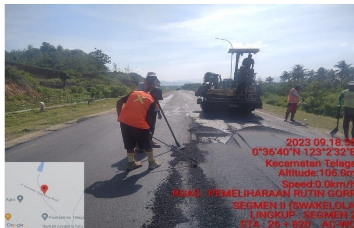
Gambar 3.6 Pekerjaan Perataan Manual
