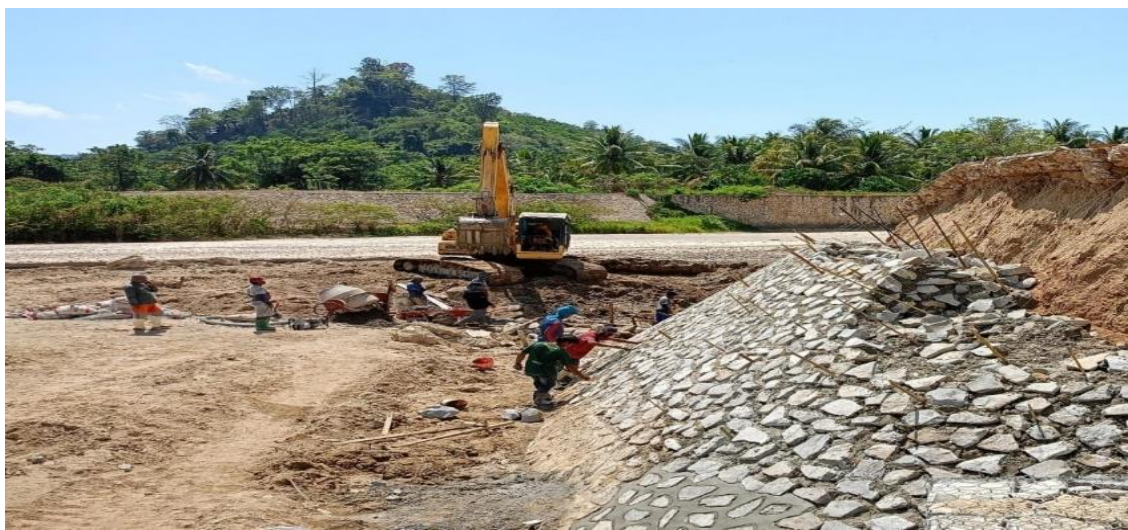
Gambar 5. Pekerjaan Tanggul Pasangan Batu
