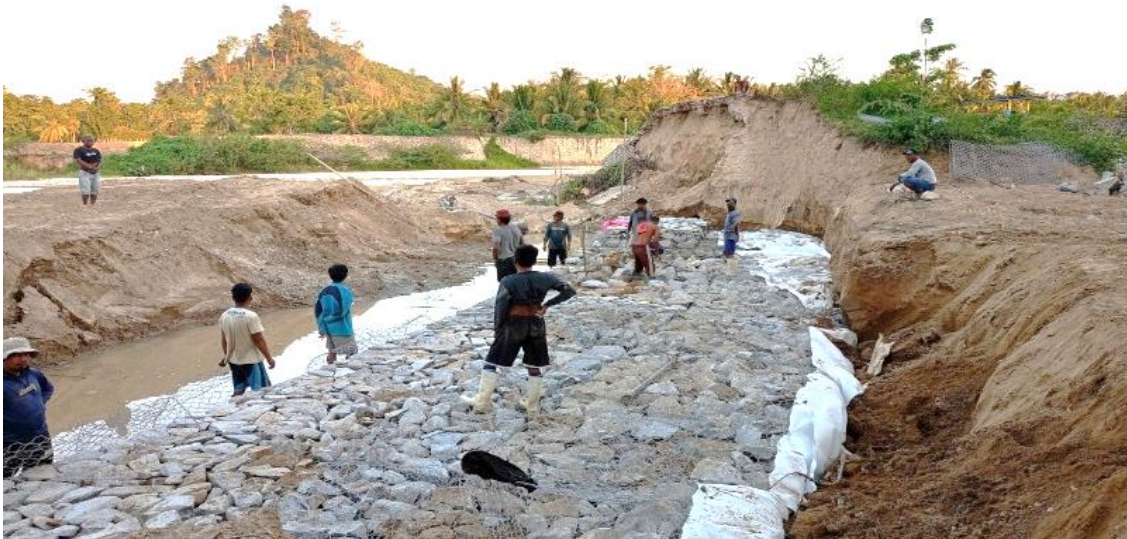
Gambar 6 Pekerjaan Pasangan Bronjong
