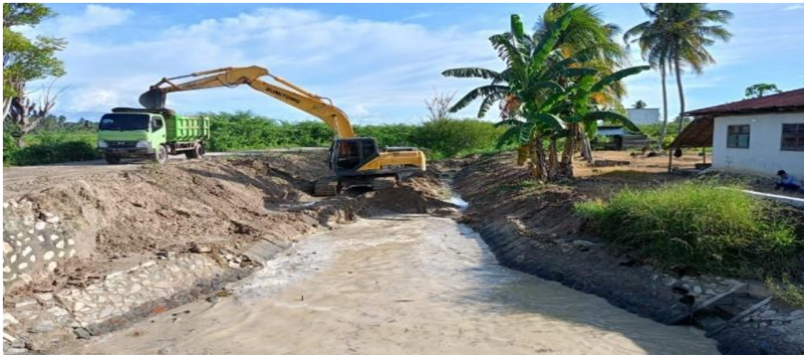
Gambar 1. Penggalan dan Penimbunan Saluran Irigasi
