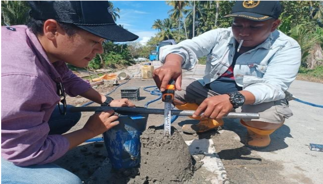
Gambar 2. Pelaksanaan Slump Test
