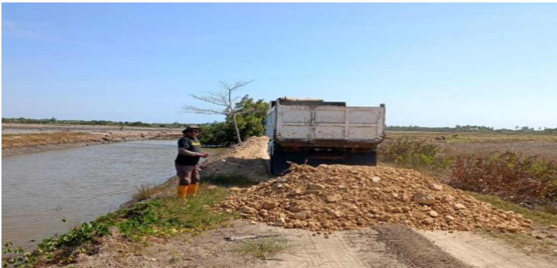
Gambar 8 Pekerjaan Jalan Inspeksi
