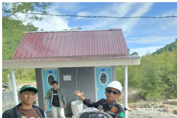
Gambar 1. Kondisi Fasilitas WC Umum Setelah Pembangunan
