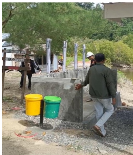
Gambar 2. Kondisi Ruang Bilas Setelah Pembangunan
