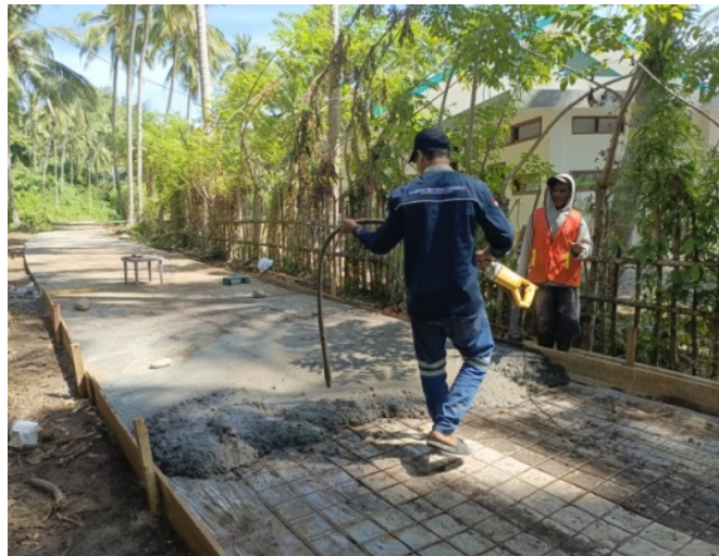
Gambar 4. Pelaksanaan Pekerjaan Rabat Beton bersama Warga
